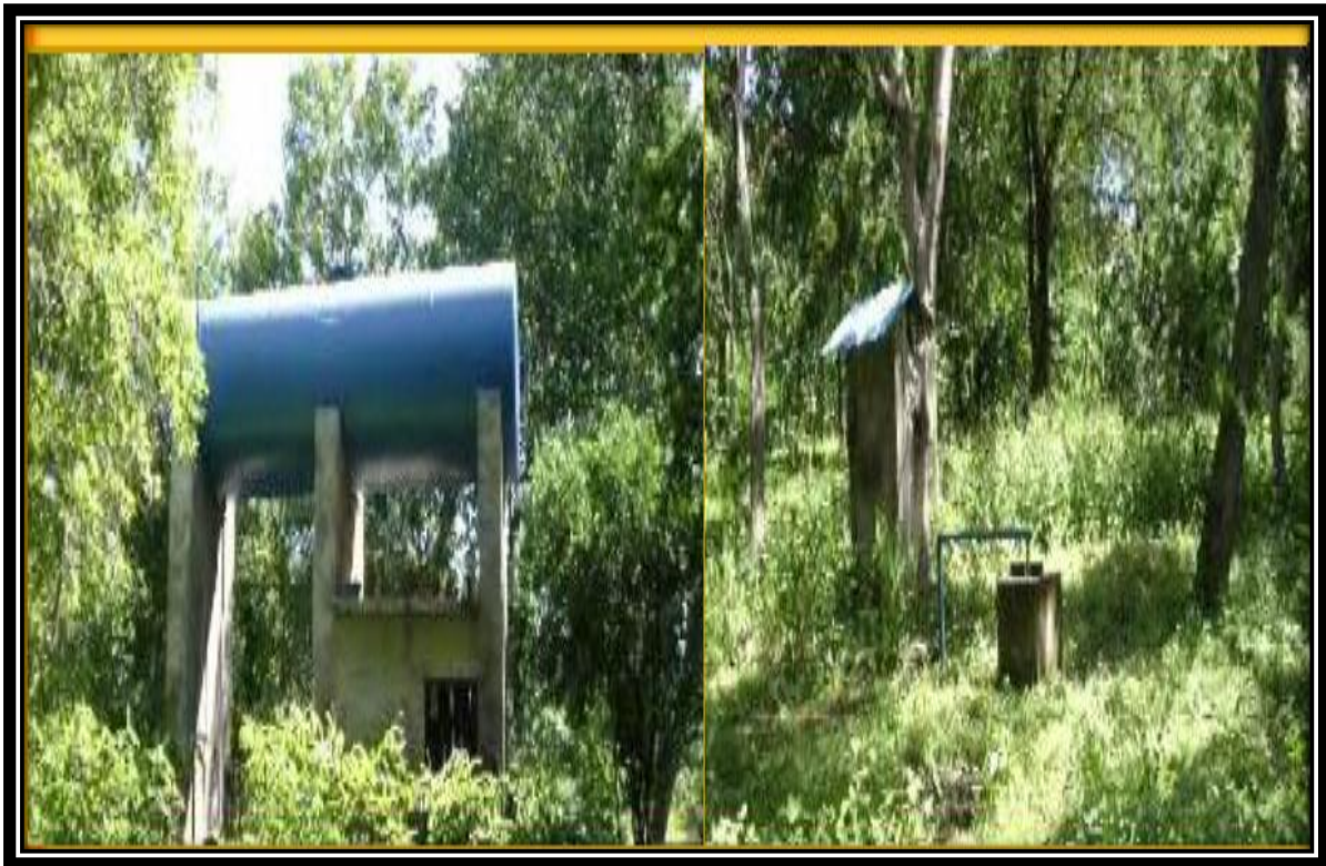
Foto No 16: Tanque de agua
