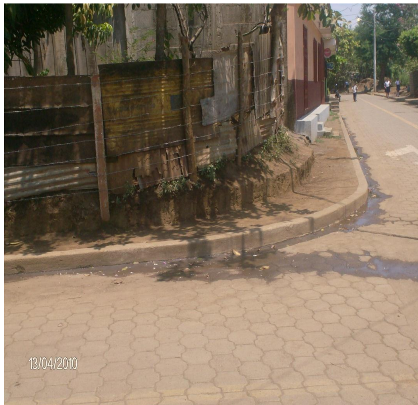
Las aguas residuales van a parar al cauce San Ramón.
