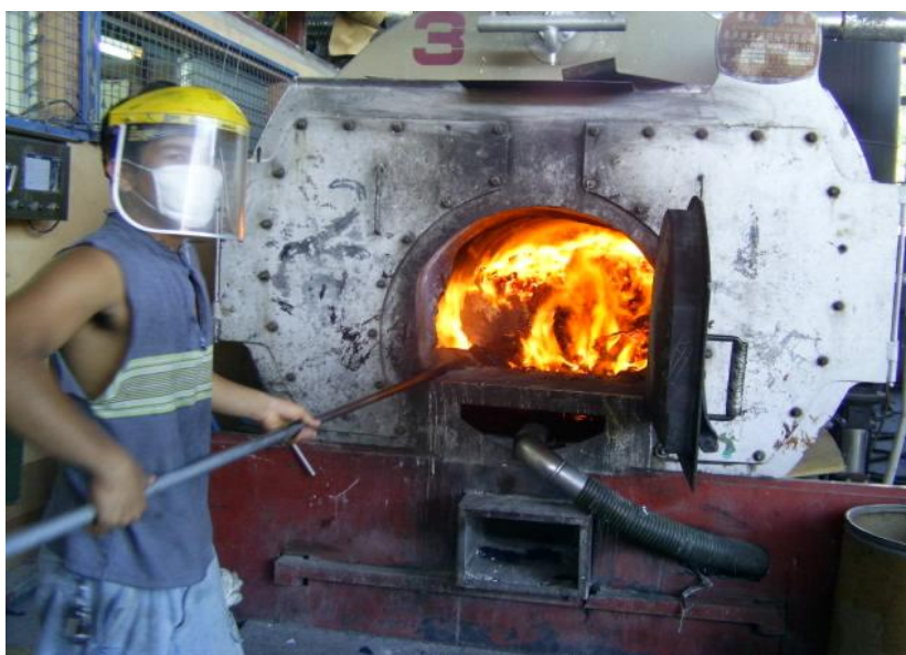
Foto 8: Incineración de residuos sólidos
