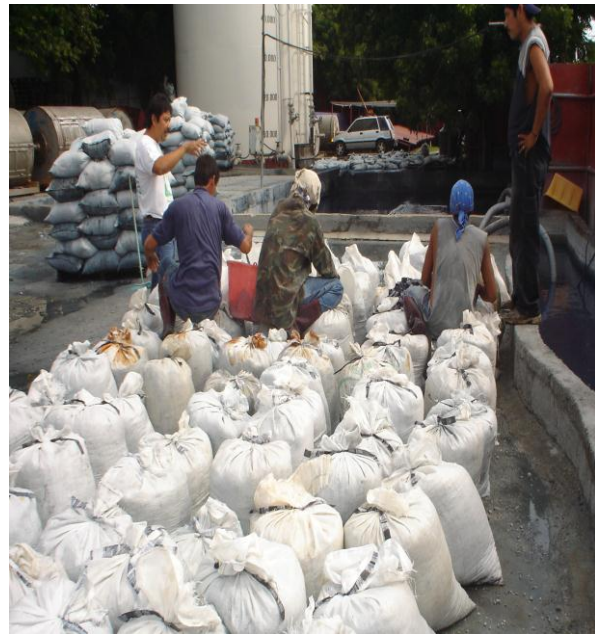
Foto 3: Extracción de lodo, pilas
