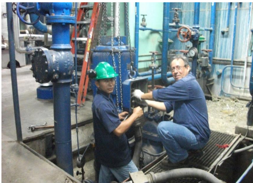
Figura 13. Motor Bba. Ext. de Condensado
