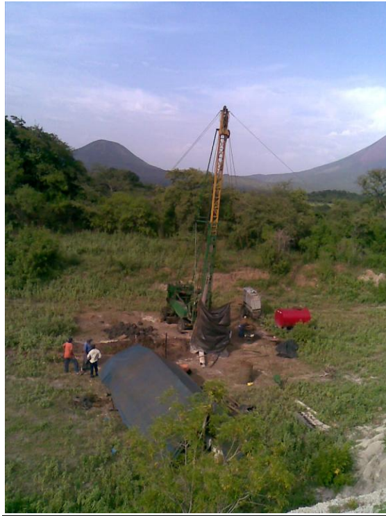
Ilustración 14: Perforación del pozo.
