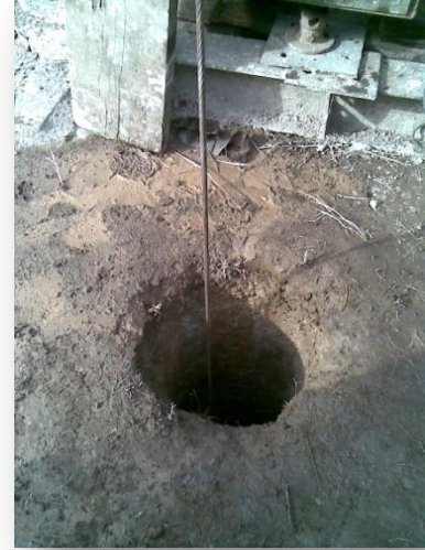
Ilustración 12: Perforación del pozo.
