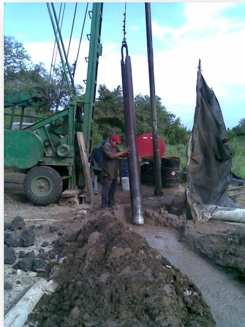
Ilustración 13: Maquinaria para la perforación.
