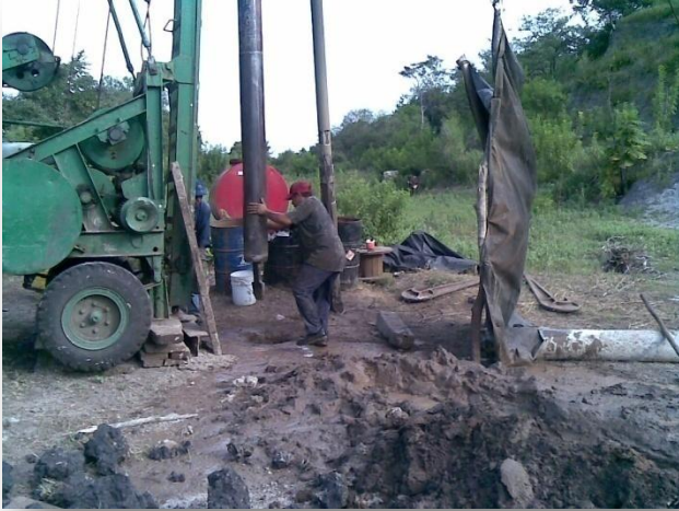
Ilustración 11: Instalación de maquinaria para la perforación.
