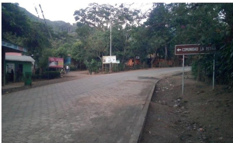
Fotografía N° 20: Carretera en proceso de construcción
