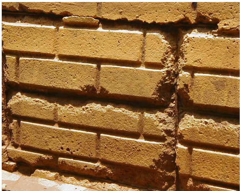
Foto 6: Columna con desplome por cortante
