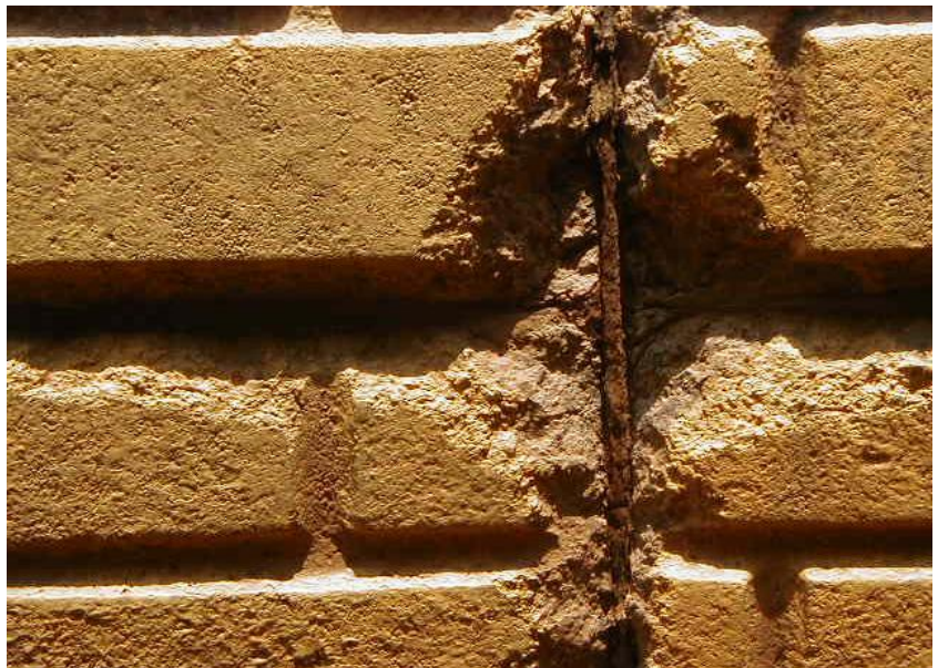
Foto 2: Pared con elementos expuestos
