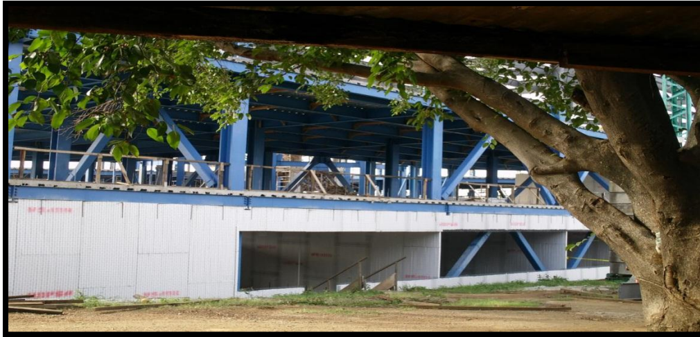
Fotografía N° 2.1 Edificio de la UNI con tecnología Covintec
