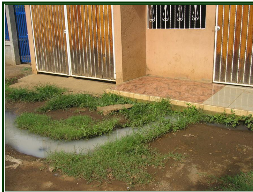
Pobladores del barrio realizan zanjas para evacuar las aguas residuales domésticas.
