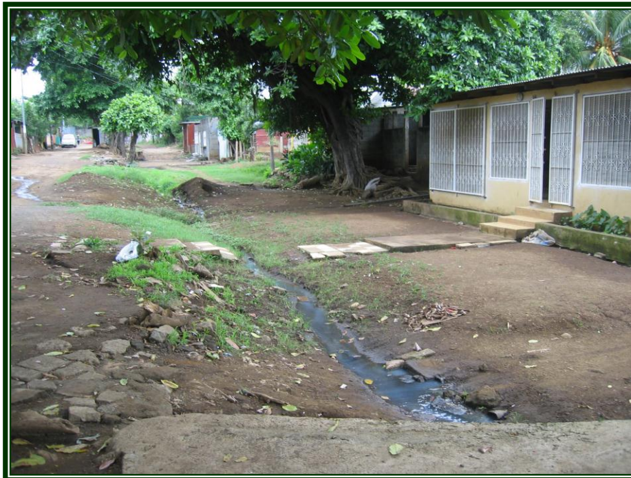
Figura 2. La mayoría de los pobladores drenan las aguas servidas a través de zanjas.
