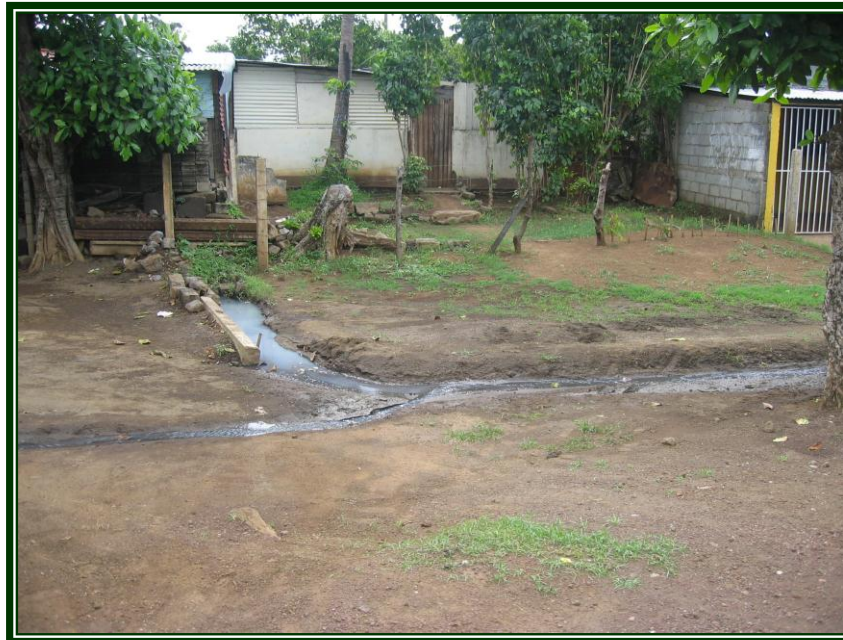
Las aguas servidas provenientes de las viviendas drenan hacia las calles internas del barrio.
