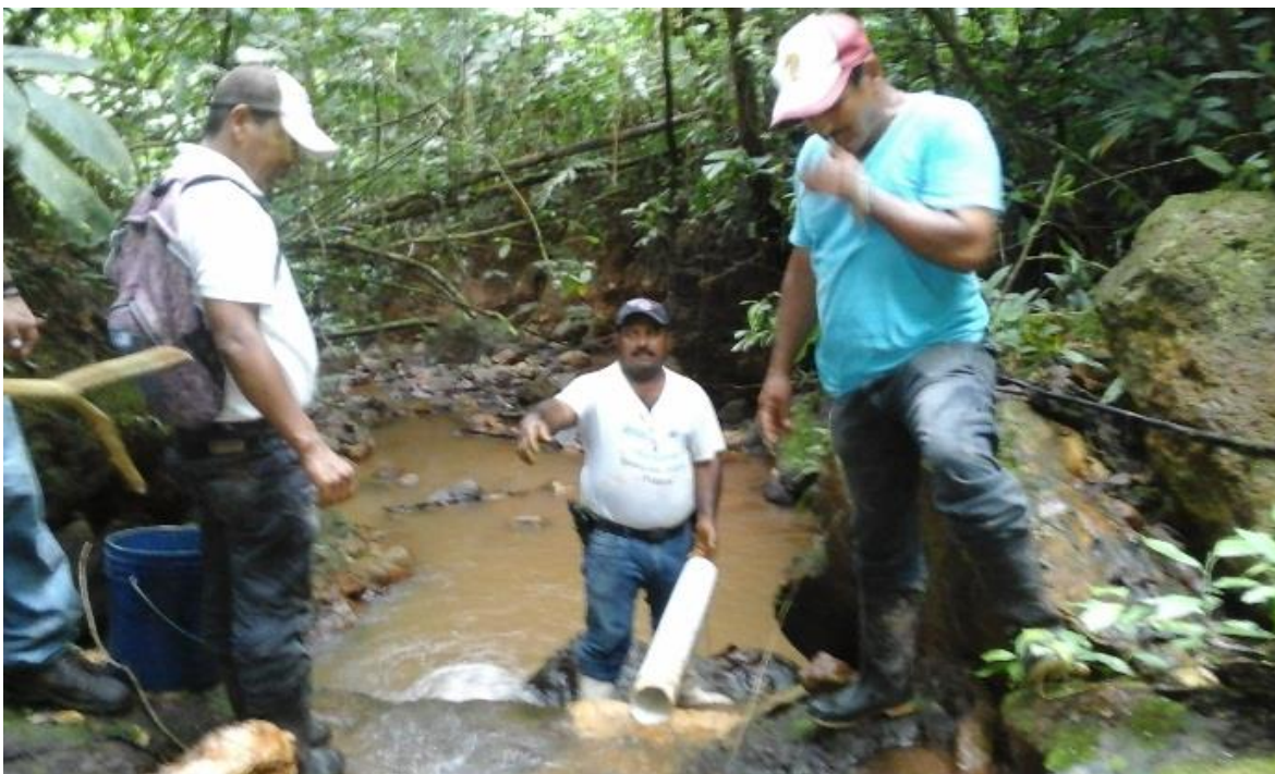
CONSTRUCCION DE DIQUE PARA AFORO VOLUMETRICO
