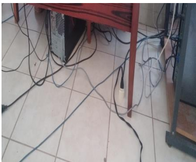
Imagen 4. Cableado de red principal desorganizado
