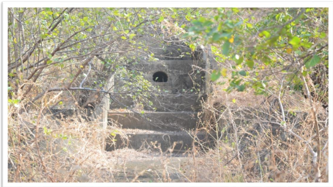
Figura 29. Salida del aliviadero del embalse. Fuente: Propia. Mendoza, J. y Tirado, D. (2017).
