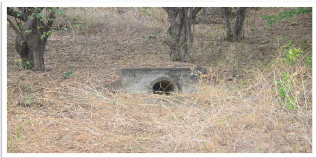
Figura 28. Entrada del Aliviadero del embalse. Fuente: Propia. Mendoza, J. y Tirado, D. (2017).
