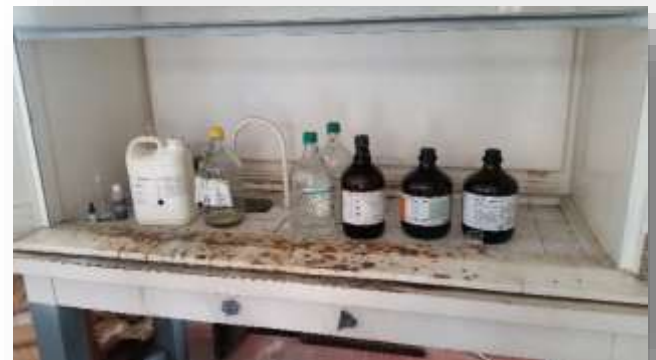
Estado de oxidación de estantes
