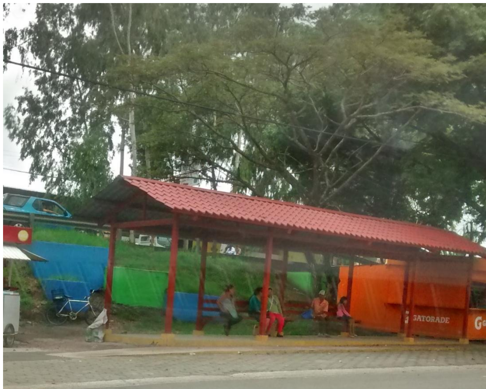
Paradero de buses ubicado en el boulevard: Una de las tres paradas que cuenta con casetas para usuarios.
