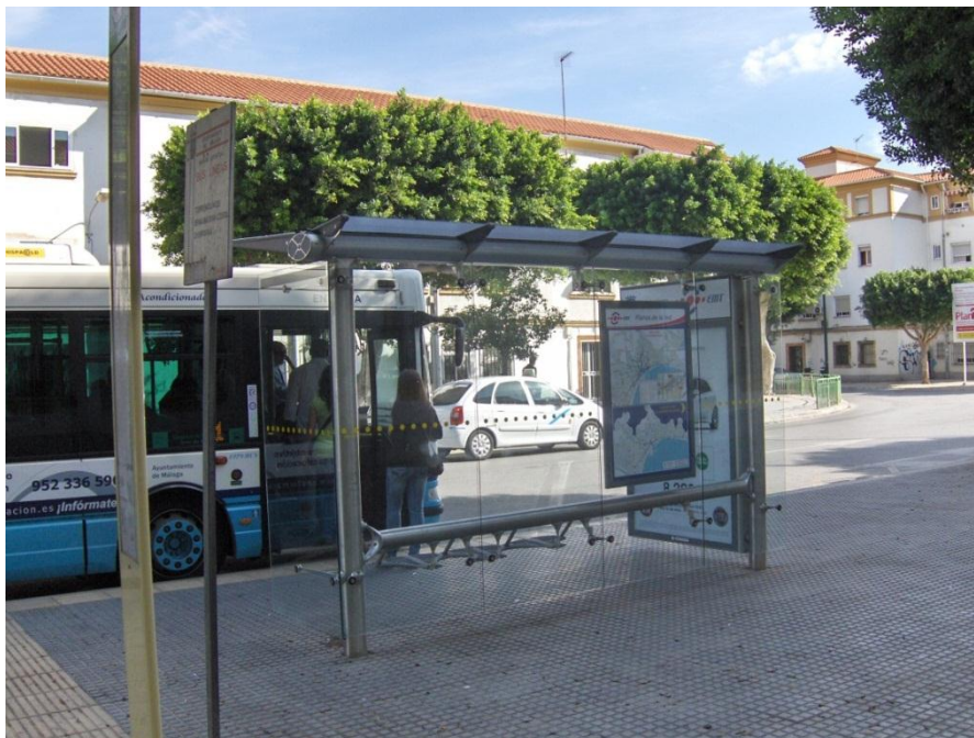
Paradero de buses para los usuarios del transporte público adecuadas.
