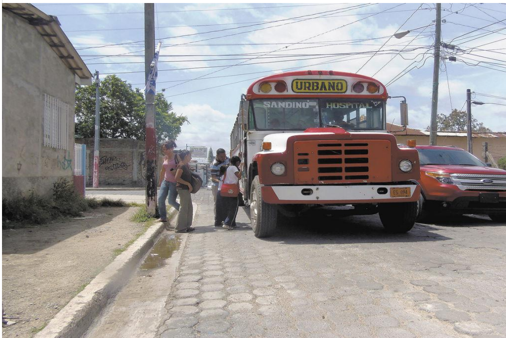
Ruta Sandino-Hospital: Paradero de buses que no cuenta con casetas para usuarios del transporte.
