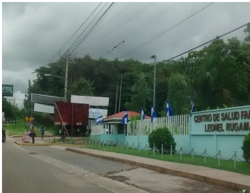
Paradero de buses ubicado en el Centro de Salud Leonel Rugama: No cuenta con casetas para usuarios.
