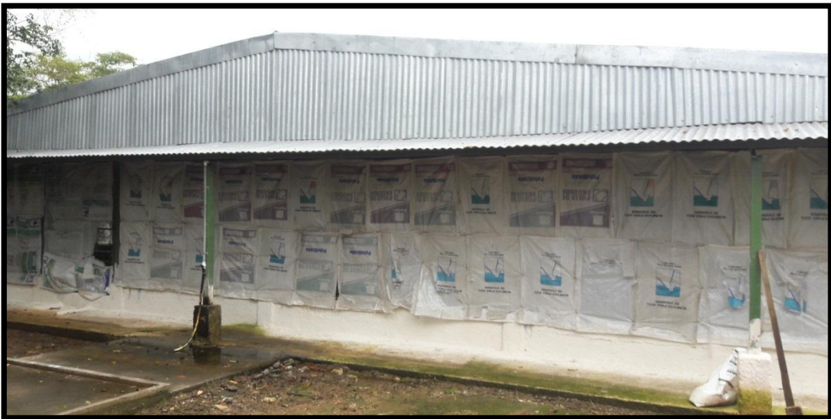
Figura N°20. GALPÓN EN ÓPTIMA CONDICIONES ESTRUCTURAL.
