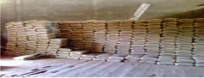
Figura N° 5 Almacenamiento de cemento.
