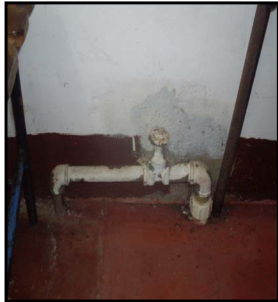
Fig. nº 17 y 18. A la derecha y a la izquierda se observa que La tubería de gas, agua y su correspondiente llave de paso no se encuentra señalizada.
