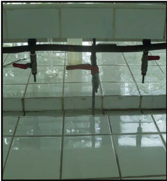
Fig. nº 17 y 18. A la derecha y a la izquierda se observa que La tubería de gas, agua y su correspondiente llave de paso no se encuentra señalizada.
