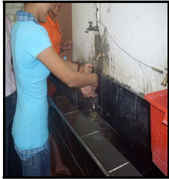
Fig. nº 37 Se observa que los residuos generados en las prácticas demostrativas son depositados en las tuberías de aguas residuales sin ningún tipo de tratamiento.
