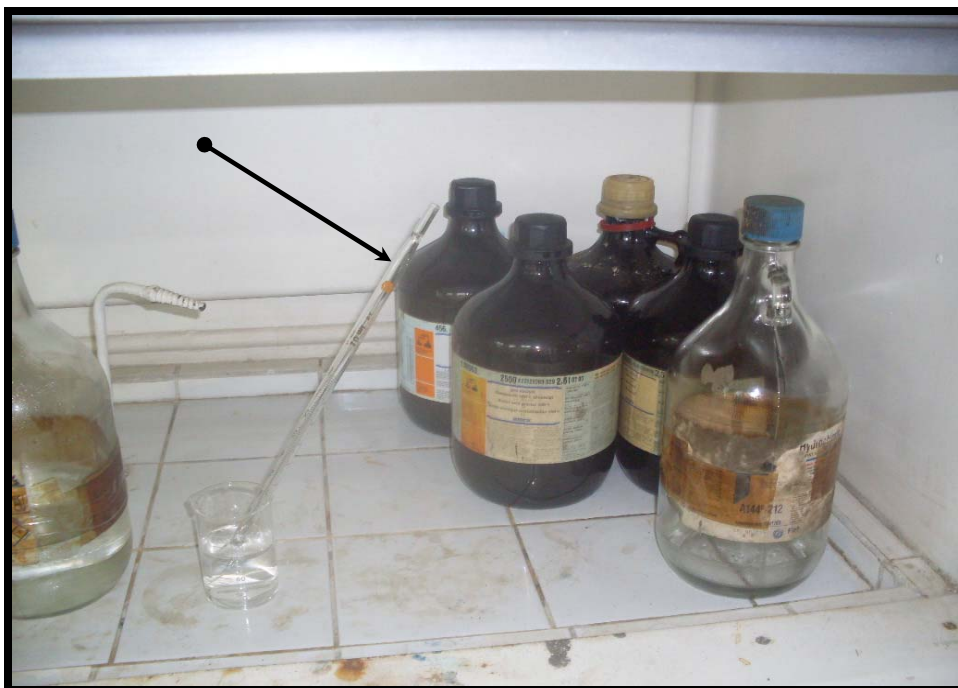
Fig. nº 10,11 y 12. En la parte superior se observa que la campana extractora de gases tiene un marcado deterioro debido a la deficiente manipulación, de parte del personal, docentes y estudiantes. En la parte inferior indica que las campana extractora de gases es utilizado como bodega de reactivos lo que permite también su deterioro.
