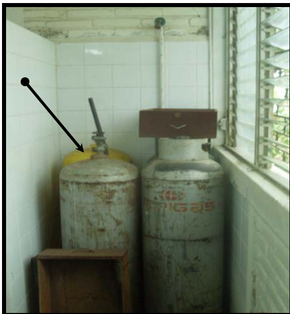
Fig. nº 19 y 20 A la izquierda se observa que el laboratorio 107 la ducha esta ocupada por cilindros de gas. A la derecha indica que el espacio físico del laboratorio también esta siendo ocupado por los cilindros de gas
