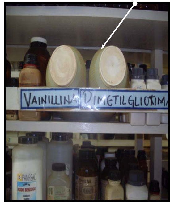
Fig. nº 24 y 25. Se indica que las divisiones de los anaqueles no alcanzan la altura requerida para el almacenamiento de reactivos con envases grandes
