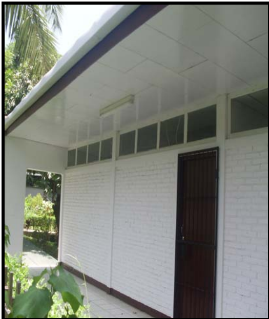
Fig. nº 34 y 35. El laboratorio 310 y la bodega de reactivo solamente tienen una puerta lo que dificulta la evacuación ante un accidente.
