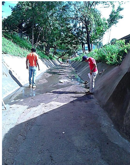
Figura 12: Visita de campo al cauce de estudio – sección aguas arriba 0+770 Fuente propia: Septiembre 2016.
