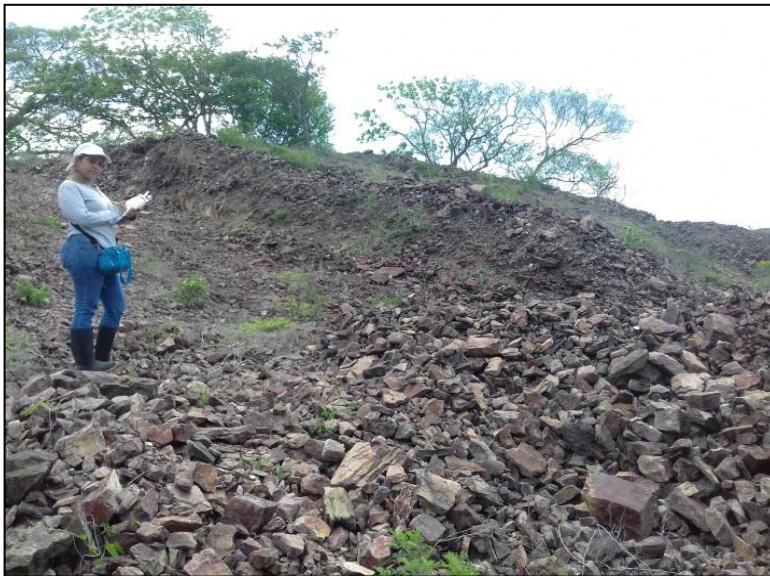
Foto N o 13. Afloramiento de andesita, con alto grado de fracturamiento. Coordenadas N647100 – E1374755.
