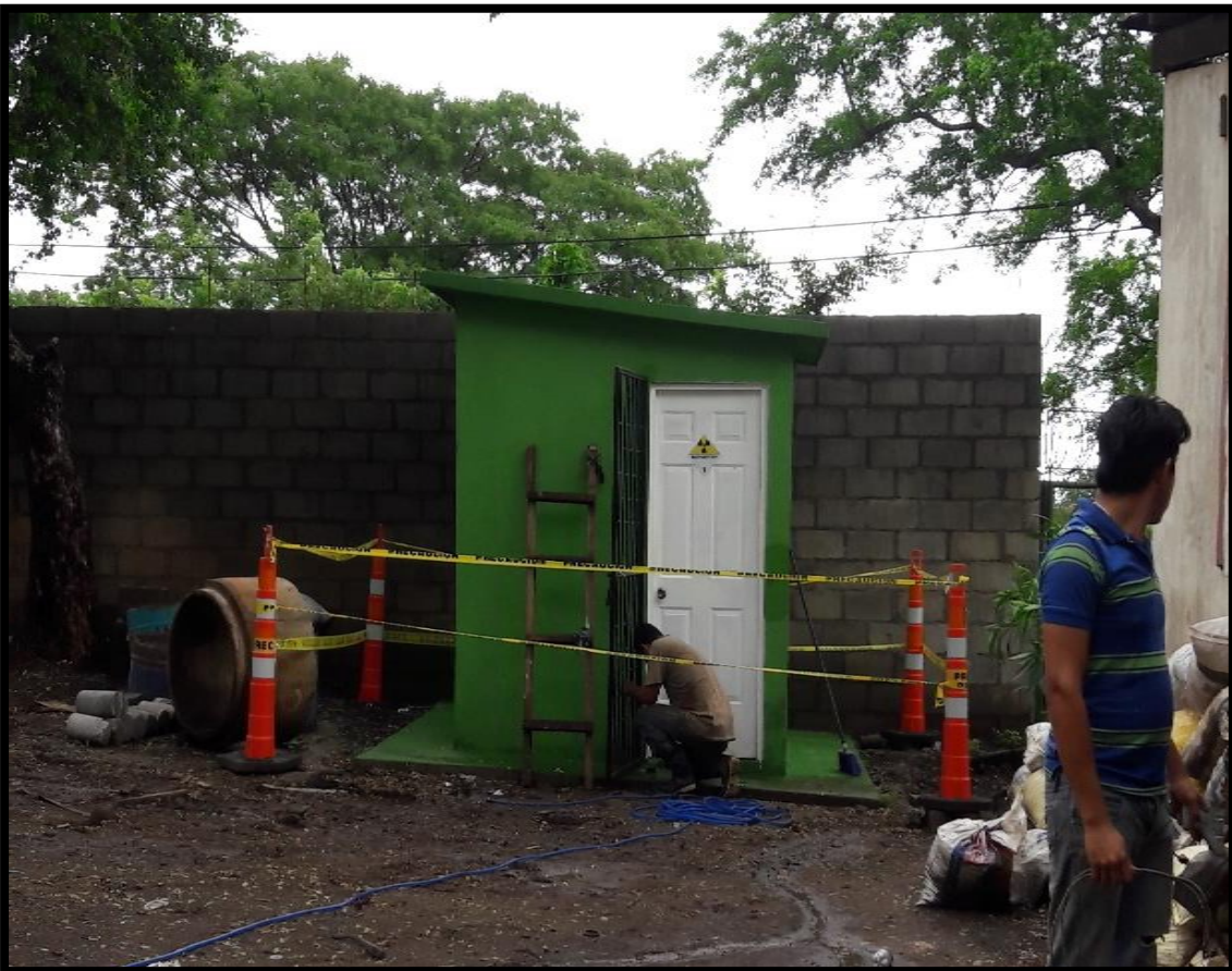
Figura 8: Caseta donde se encuentra la maquinaria que genera radiación ionizante
