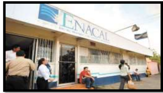
Instalaciones de ENACAL
