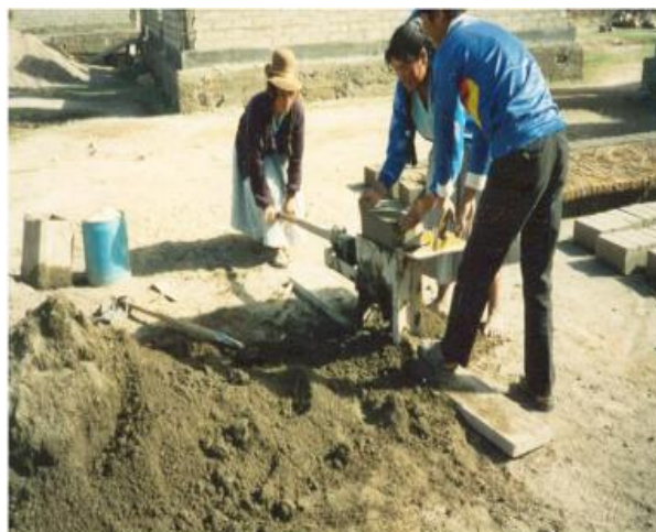
Figura 19. Elaboración de adobes con la máquina Cínva - Ram
