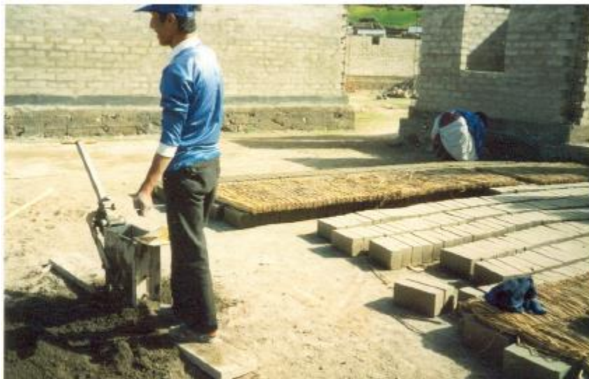
Figura 23. Curado y almacenamiento de los bloques. 1er manera
