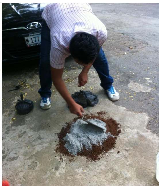
Ilustración 8. Homogenizado colocación y compactación del adobe
