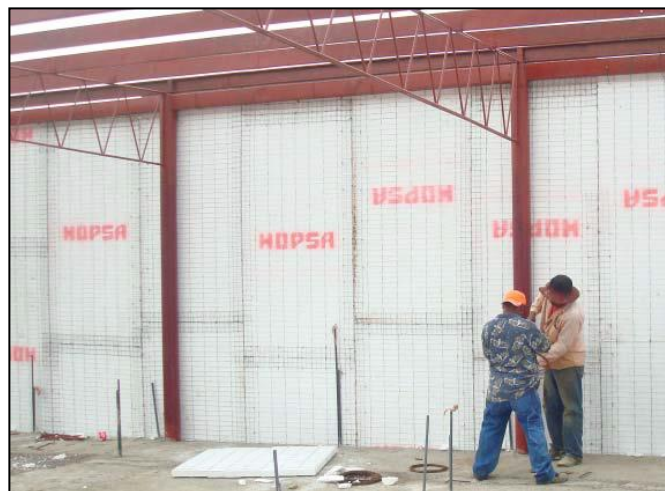
Figura 11: Unión de paneles Covintec a estructura metálica
