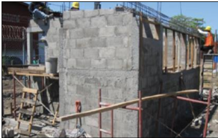
Figura 2: Sistema Mampostería confinada
