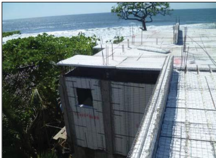
Figura 12. Unión de paneles Covintec a estructuras de concreto
