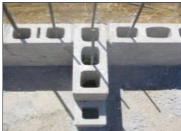
Figura 1: Sistema Mampostería Reforzada
