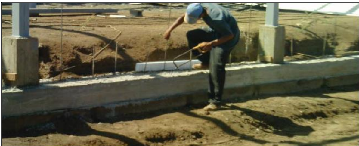
Figura 8: Anclaje a viga de Cimentacion
