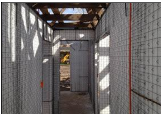
FIGURA 5: Sistema Panel de Covintec
