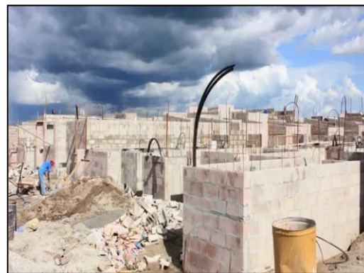
FIGURA 6: Sistema Mampostería Confinada
