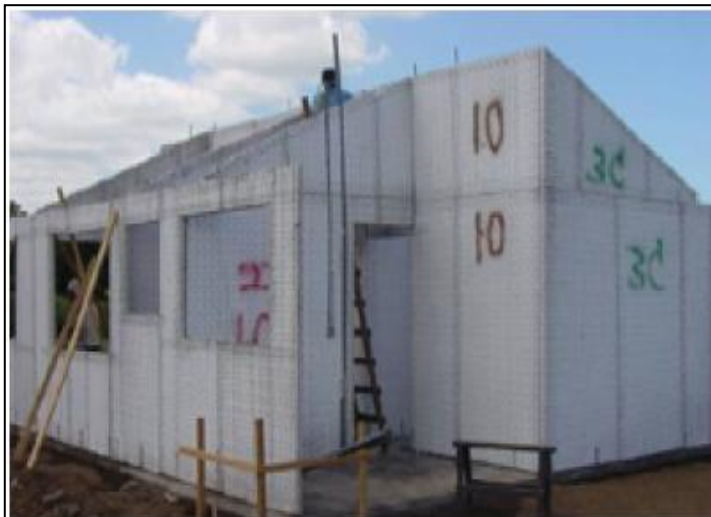
Figura 4: Sistema constructivo Covintec
