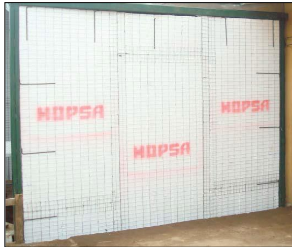
Figura 10: Paredes solo covintec
