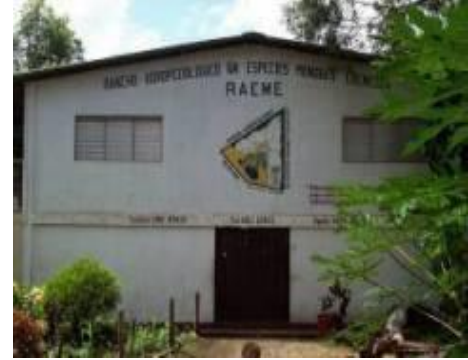
Edificio Principal del Rancho
