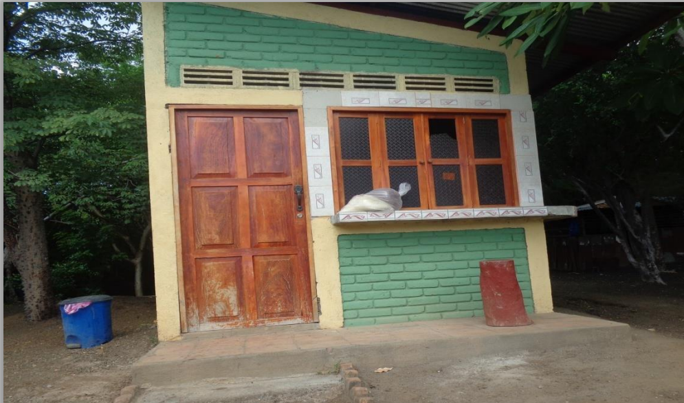
Infraestructura: Cocina habilitada para el uso de los trabajadores de la reserva (foto tomada en visita de campo)
