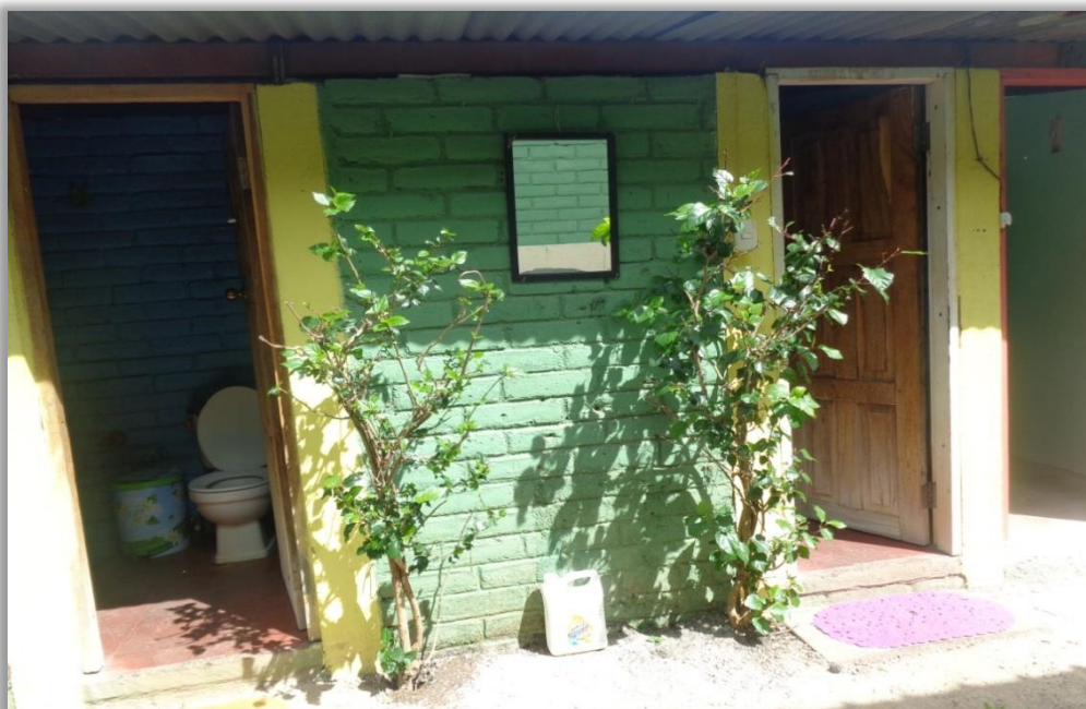
Infraestructura: servicios de baños e inodoros (foto tomada en visita de campo).
