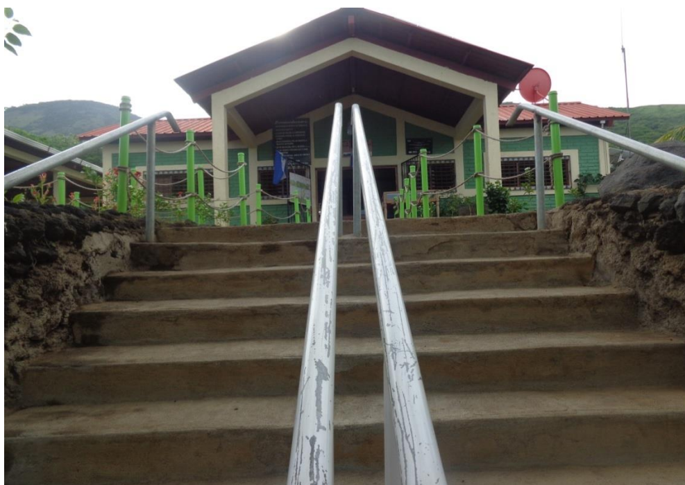
Infraestructura: Centro de información remodelada (foto tomada en visita de campo).
