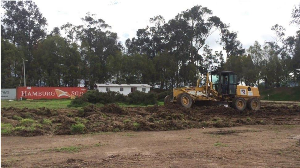
fig. 5 imagen de motor-niveladora en trabajo de descapote fuente: (imágenes google)
