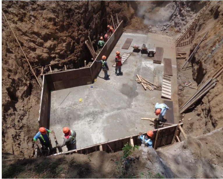
Foto#3-Armado de formaleta, llena de losa de limpieza en estribo N° 2- Puente Momotombo-Carretera La Paz Centro – Malpaisillo. Fuente: Edicro S.A.
