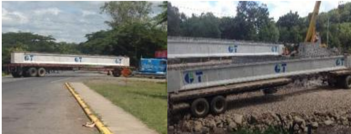
Foto#17Traslado. Fuente: Concretera Total
