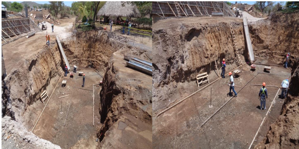
Foto#2-Conformación de piso para colado de concreto en losa de limpieza, estribo N° 1-Puente Momotombo-Carretera La Paz Centro – Malpaisillo. Fuente: Edicro S.A.
