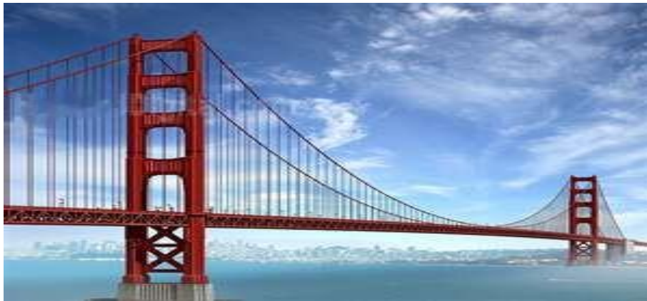
Figura #7-Puente Colgante- Facultativa – Puentes - Apuntes de Puentes - Ing. Bayardo Altamirano
