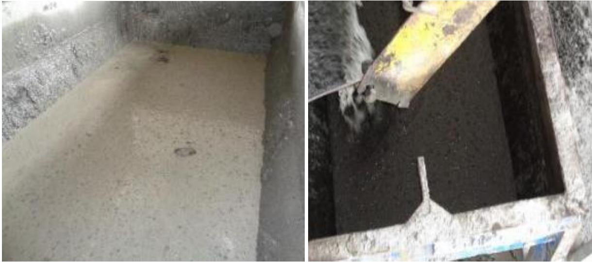
Foto#9-Fabricación del concreto para Vigas. Fuente: Concretera Total
