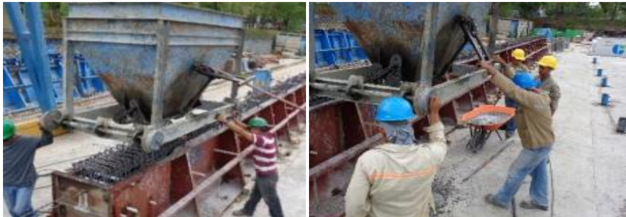
Foto#13-Colocación o colado del Concreto. Fuente: Concretera Total
