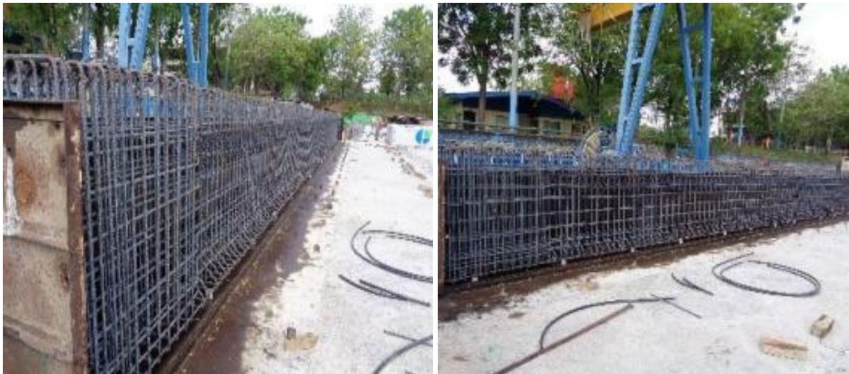
Foto#10-Colocación del Acero. Fuente: Concretera Total
