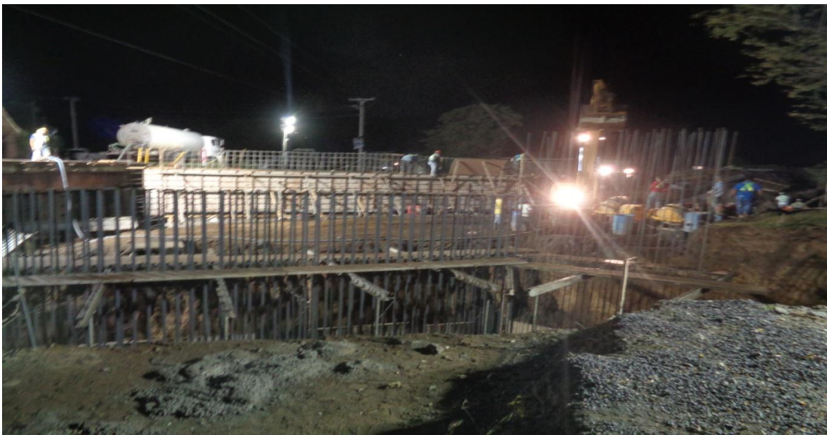
Foto#8-Colado de concreto en pared y aleton N° 1, aguas abajo-Puente Momotombo- Carretera La Paz Centro – Malpaisillo. Fuente: Edicro S.A.
