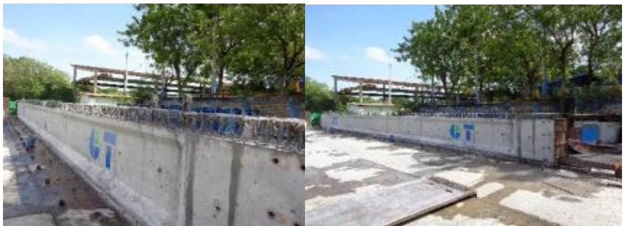
Foto#14Curado. Fuente: Concretera Total
