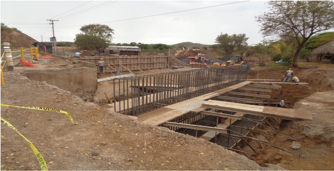
Foto#7-Proceso armado de acero de refuerzo y colocacion de formaletas en estribo y colocacion de formaletas en estribo N° 2, aguas arriba-Puente Momotombo-Carretera La Paz Centro – Malpaisillo.
