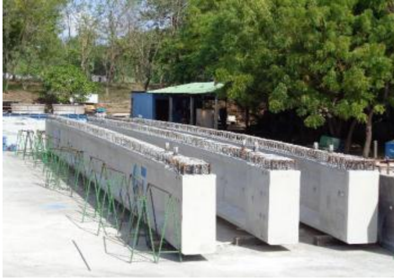
Foto#15-Resane. Fuente: Concretera Total
