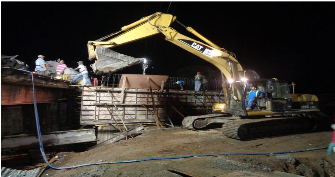
Foto#6-Colada de concreto en pared central y aletón izquierdo, estribo N° 1 a nivel de Asiento de Viga Puente 10+701-Puente Momotombo- Carretera La Paz Centro – Malpaisillo. Fuente: Edicro S.A.
