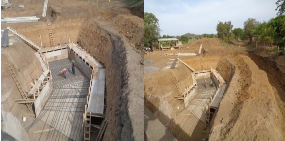
Foto#5-Proceso armado de acero de refuerzo y colocacion de formaletas en estribo y colocacion de formaletas en estribo N° 1, aguas arriba, en puente Puente Momotombo-Carretera La Paz Centro – Malpaisillo. Fuente: Edicro S.A.
