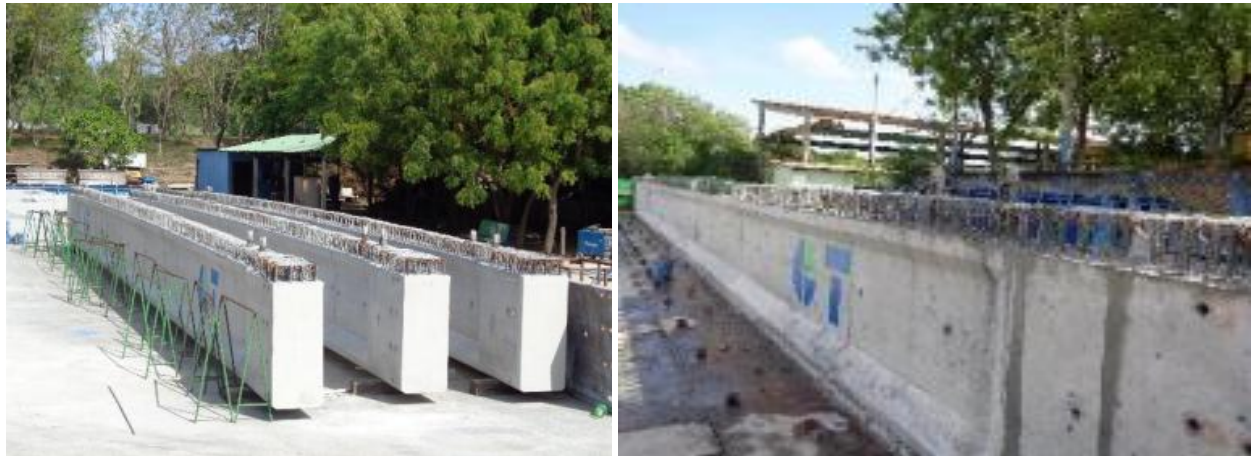
Foto#16-Vigas Terminadas. Fuente: Concretera Total
