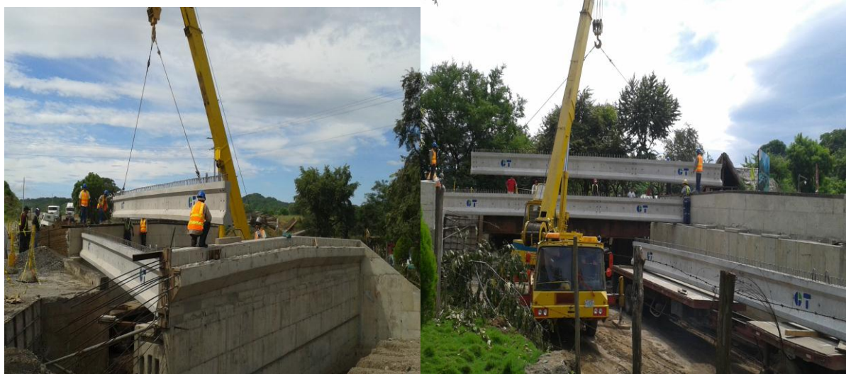
Foto#18-Instalación. Fuente: Concretera Total
