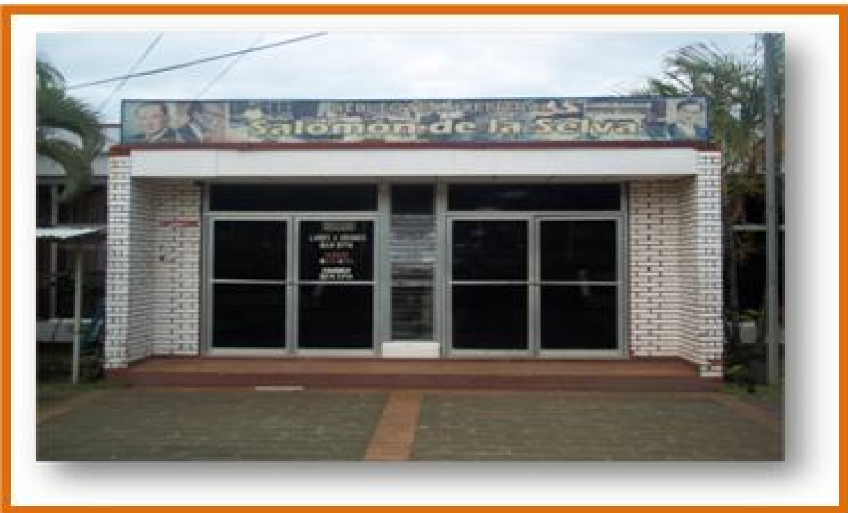
Entrada actual de Biblioteca Central "Salomón de la Selva" UNAN-Managua
