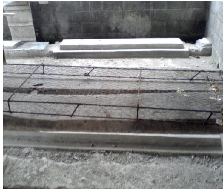
Foto N°4: colocación refuerzo de malla.
