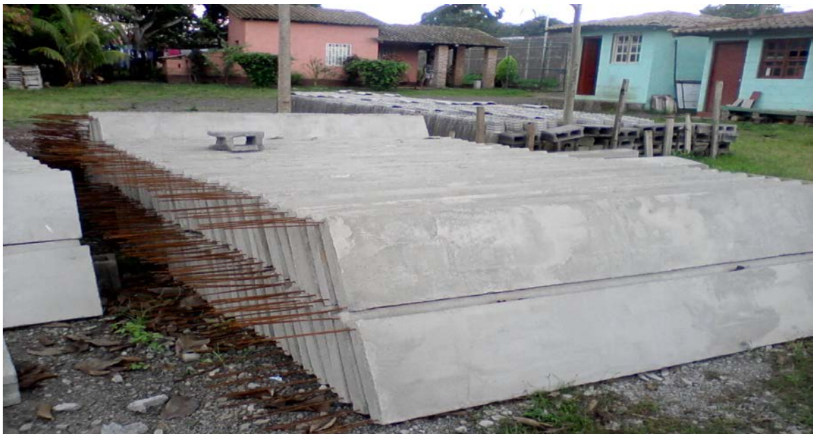
Foto N°10: Losa de concreto área de secado.
