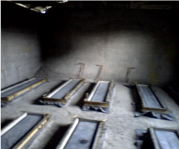
Foto N°5: Preparación de los moldes.
