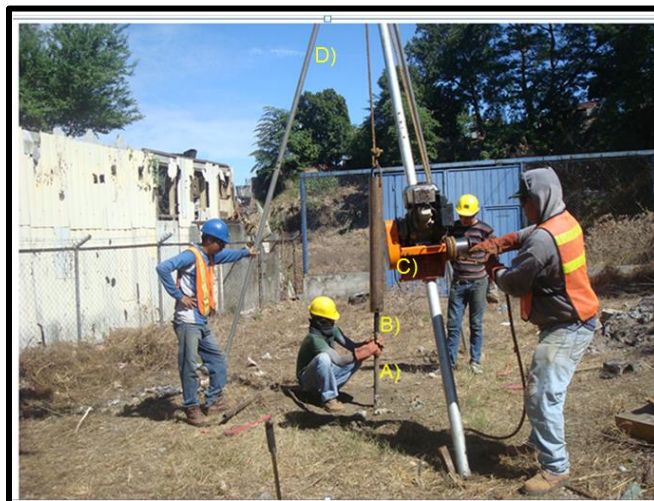
Figura 3.12. A) Varillas de muestro B) Caída del martillo C) Motor D) Trípode
