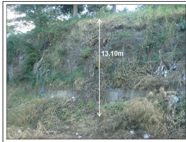
Figura 2.3. Talud ubicado en la Loma Chico Pelón
