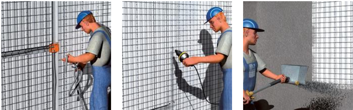
Imagen9 Ensamblaje de los paneles e instalación de accesorios eléctricos y sanitarios. Fuente: Grupo de Trabajo.
