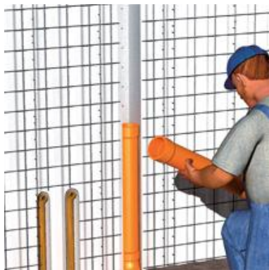
Imagen10 Listo para aplicación del revoque. Fuente: Grupo de Trabajo.
