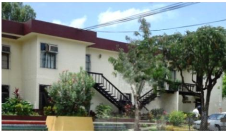
Imagen 17. Escaleras de acceso a segundo nivel. Fuente: Grupo de Trabajo.
