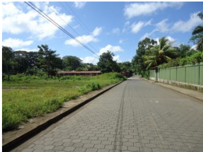
Imagen 37. Servicio de energía eléctrica. Fuente grupo de trabajo.
