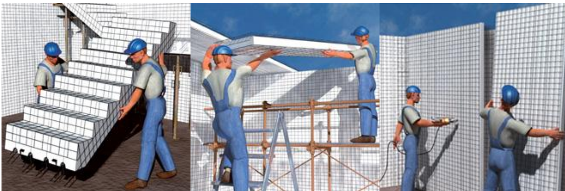
Imagen8 Transporte y montaje de los paneles EMMEDUE. Fuente: Grupo de Trabajo.
