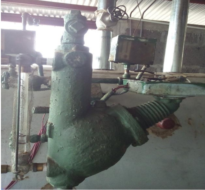
Ilustración 6: Medidor del nivel del agua. Fuente:
