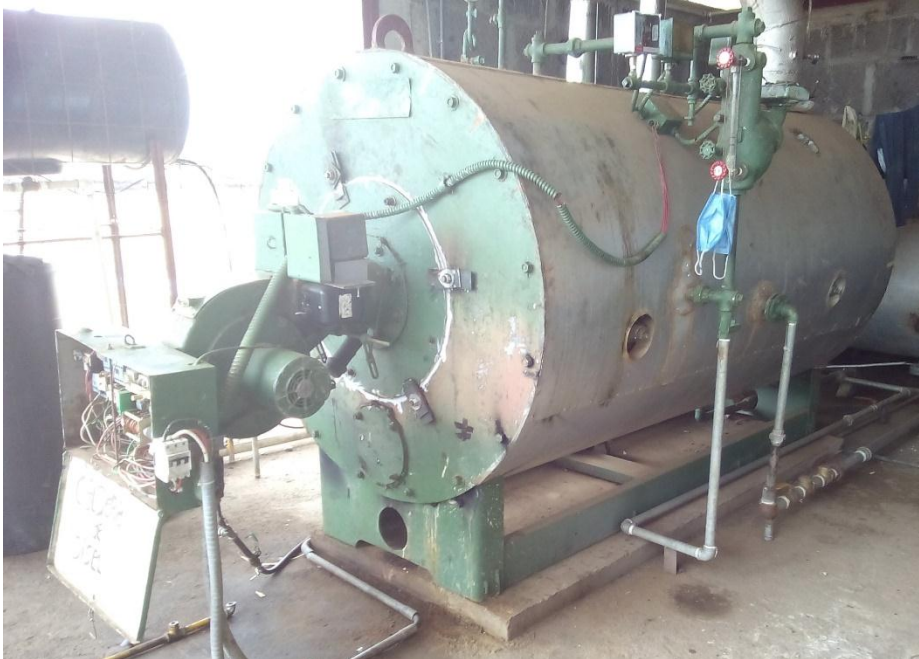
Ilustración 12: Caldera pirotubular.
