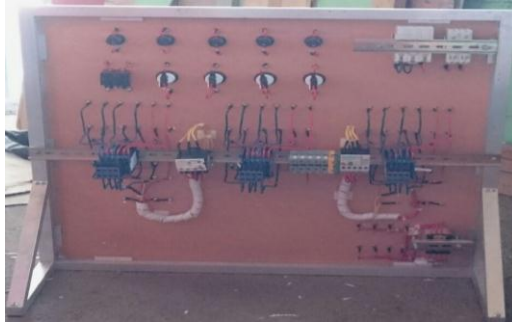
Ilustración 22 Cableado y soldado de cada una de las conexiones al Acrílico
