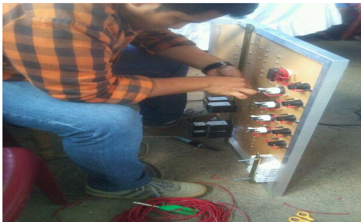
Ilustración 68 Instalación de dispositivos eléctricos
