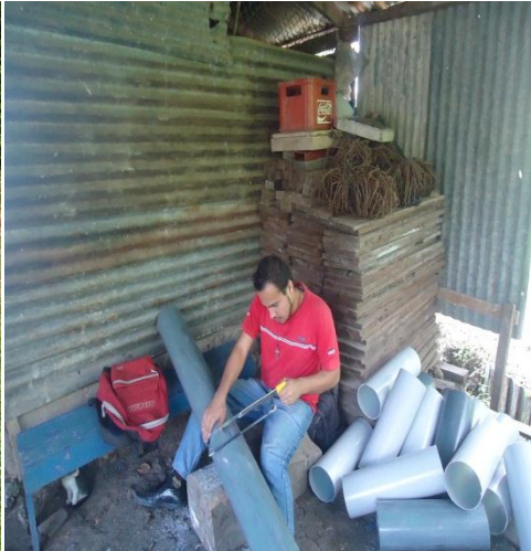
Foto 2: Corte de tubos
