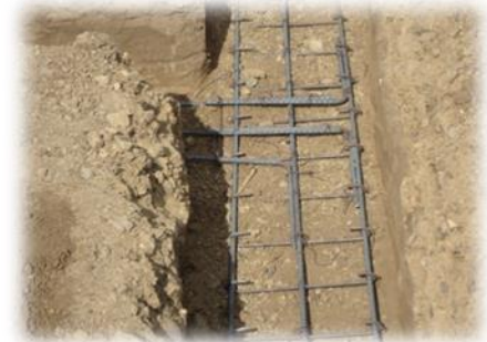
Foto 27: Fundaciones de vivienda
