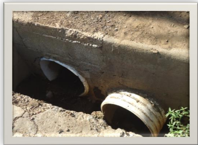
Foto 24: Tubos PVC para drenaje Pluvial
