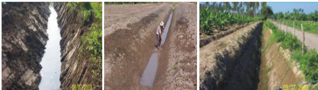
Imagen 3: Construcción de drenes
