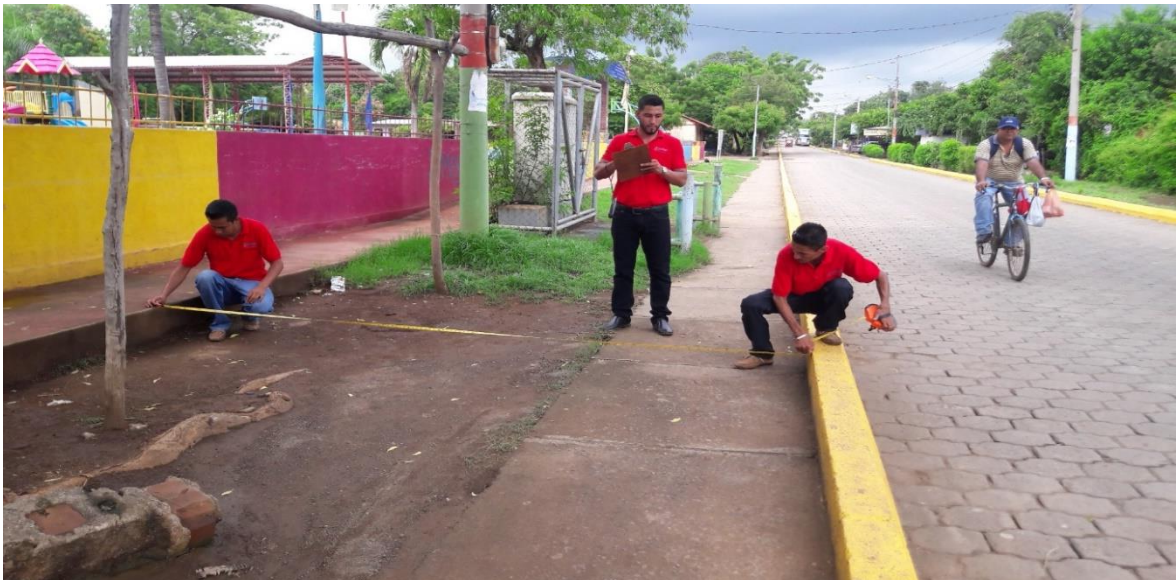
8.4.2. Levantamiento con cinta de derecho de vías.
