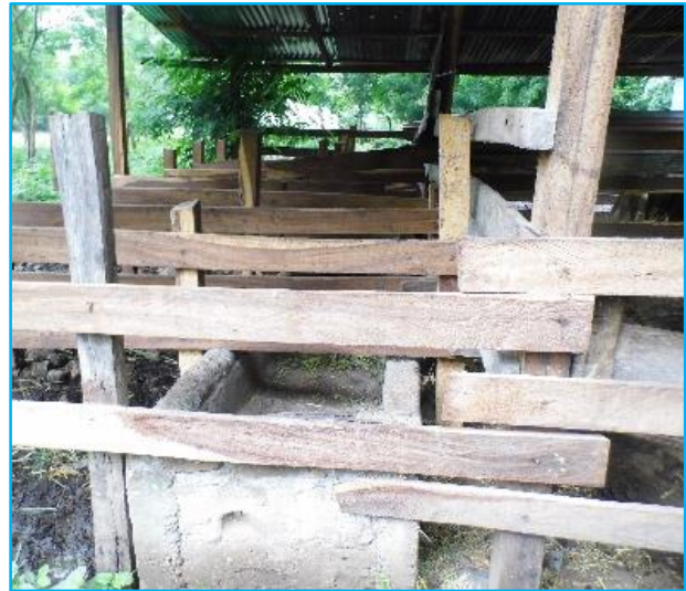
Fuente: Elaboración propia Foto 42: Estructura del Corral de la Parcela de Lino y Daysi
