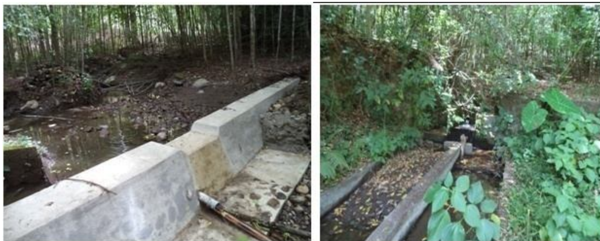
Figura 18. Captación y desarenador en la Breiera
