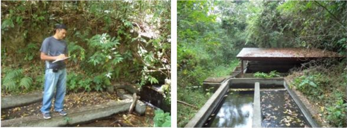
Figura 4. Inspección del desarenador durante la primera semana
