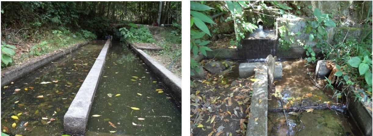
Figura 38. Deficiencia de operación y mantenimiento en desarenador.
