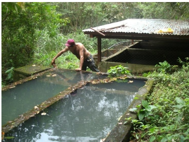
Figura 16. Operador del sistema realizando revisión del desarenador
