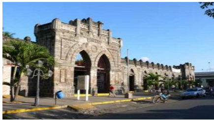
Fachada de la entrada del mercado de artesanías
