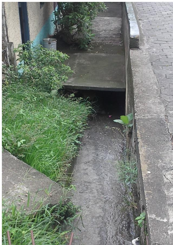
Inicio del canal 1
