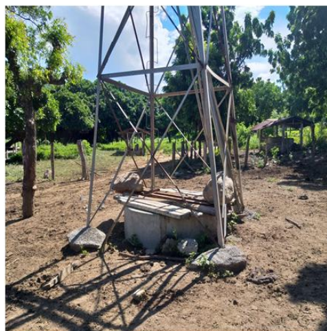
I)- Medición en pozo excavado, El Tamagás.
