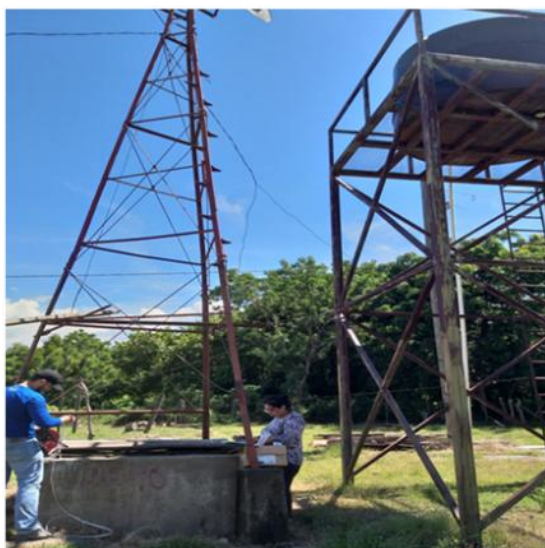
A)- Medición preliminar de niveles freáticos y parámetros de campo.
