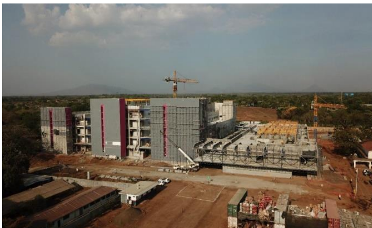
Figura 3. Construcción del HEODRA.
