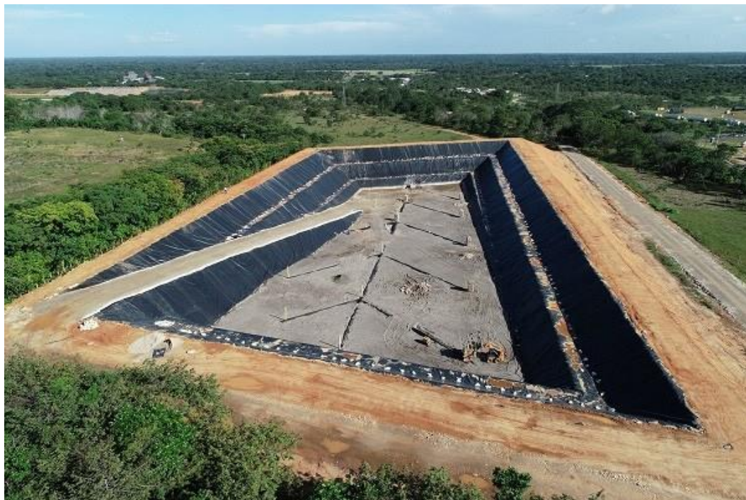
Ilustración 23. ANEXO 6: Implementación del método de trinchera 1
