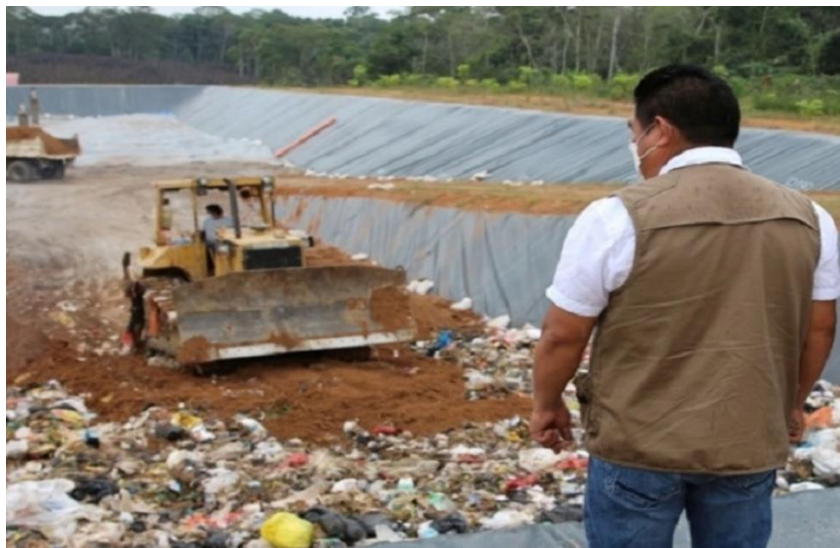
Ilustración 24. ANEXO 7: Implementación del método de trinchera 2
