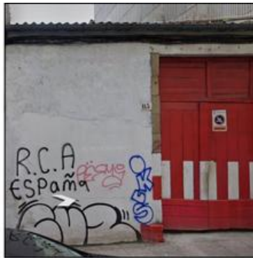
Edificación al costado oeste de la Clínica
