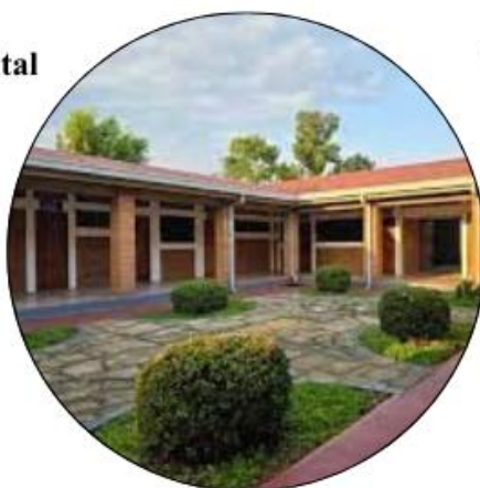
Vista a Patio interior y Pasillos
