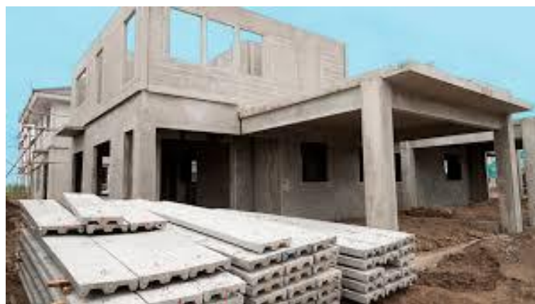
Sistema constructivo prefabricado
