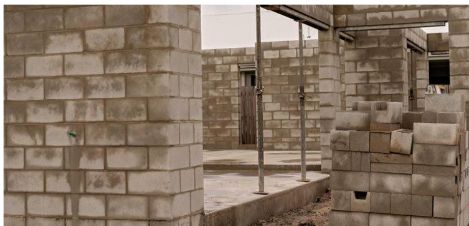
Sistema constructivo tradicional
