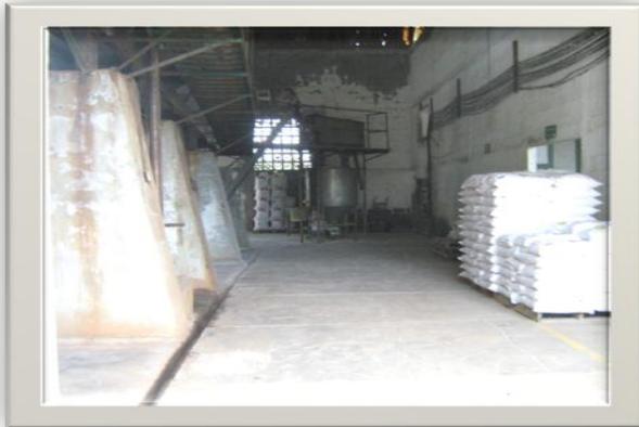
Foto1.2.2.a.pisos con desagüe adecuado
