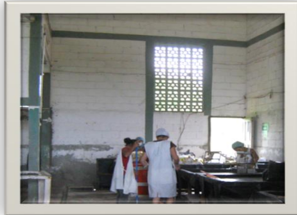
Fotos 1.2.3.c y 1.2.3.d. pared de concreto pero sin curvatura sanitaria área de empaque y secado.
