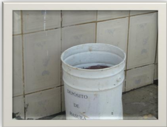
Foto: 1.5. a. Presencia de depósitos de desechos De desechos sin tapaderas.
