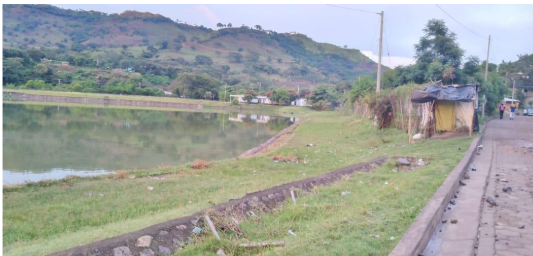
Imagen 5. Foto de la planta de tratamiento de aguas residuales ubicada en barrio Sor María Romero Matagalpa. Fuente: Foto tomadas por el autor.
