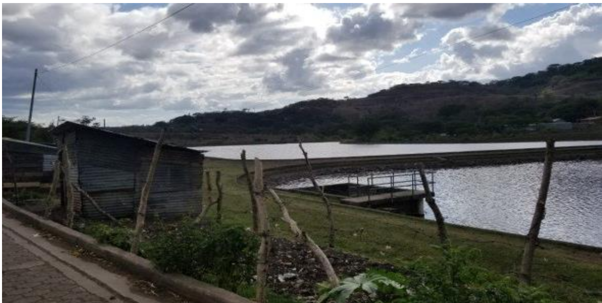
Imagen 11. Foto de la planta de tratamiento de aguas residuales ubicada en barrio Sor María Romero Matagalpa. Fuente: Foto tomadas por el autor.
