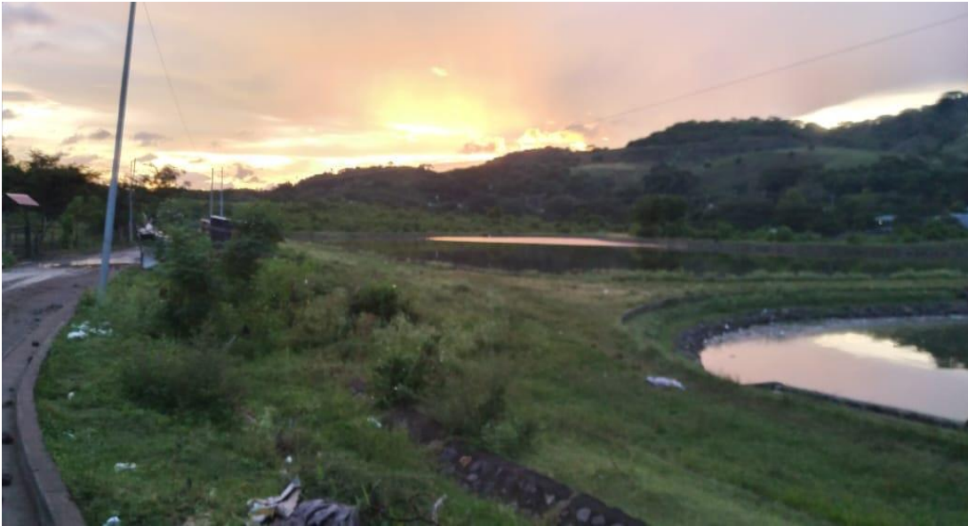
Imagen 6. Foto de la planta de tratamiento de aguas residuales ubicada en barrio Sor María Romero Matagalpa. Fuente: Foto tomadas por el autor.
