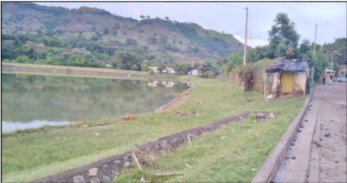
Ilustración 5. Foto de la planta de tratamiento de aguas residuales (PTAR) y las casas que viven en la periferia.
