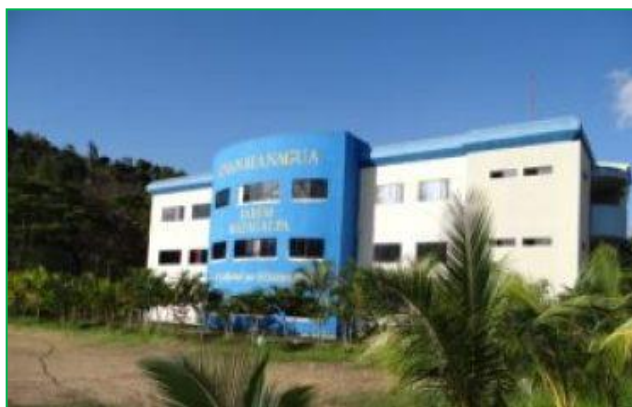
Figura 5: Fachada frontal del Edificio 30 aniversario de la FAREM-Matagalpa
