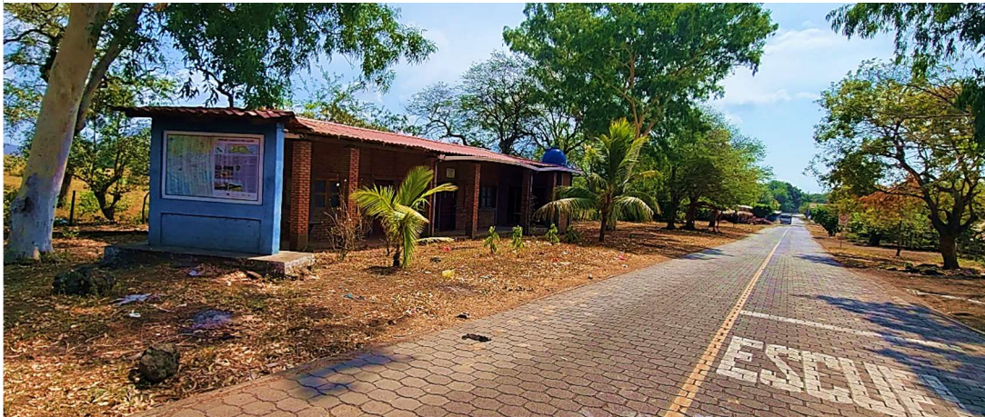
Figura 35: Instalaciones del Centro de Información para el Turismo propiedad de AFOTUR
